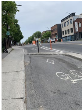
Figure 8 : Bordure en béton, VAS Christophe-Colomb à la hauteur du Parc des Carrières
